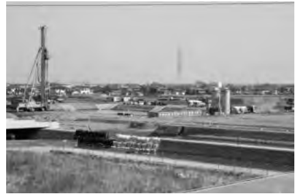
(跨線橋から見る吉川美南駅東口開発の様子)
