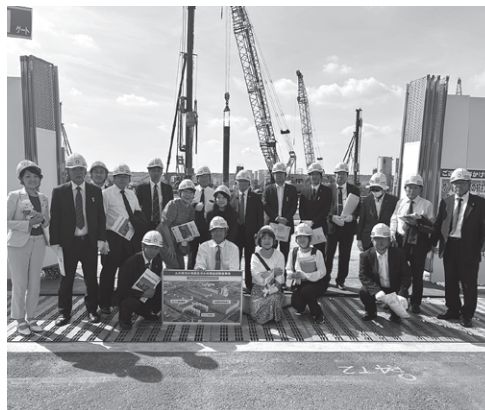
高度浄水処理施設整備工事場所の様子
